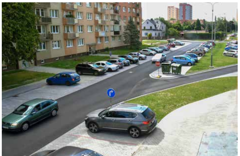
Rekonstrukce ulice Mjr. Nováka a parkoviště / 55 mil. Kč
